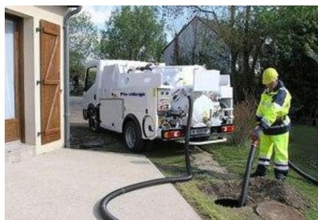
Les ouvrages doivent être vidangés autant que de besoin, mais pas à l'excès non plus, lorsque le taux de remplissage en boues atteint 50% du volume utile (ou 30% pour les micros stations d'épuration).
